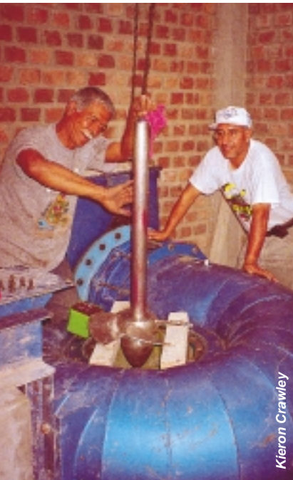
▲ Installing the runner, 25 kW low head turbine, Las Juntas, Peru.
